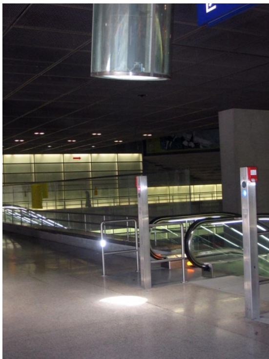
Slika 2: Svetlobni vodniki prenašajo naravno svetlobo s površja v podzemni prostor. postaja podzemne železnice, Potsdamer Platz, Berlin, 2006.
