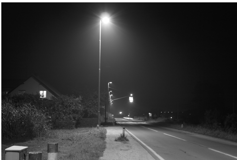
Slika 5: Če uporabimo popolnoma zasenčene svetilke, se nam blešči samo prva, morda še druga svetilka, vse naslednje svetilke se nam ne bleščijo. Brez bleščanja imamo lahko nižji nivo osvetljenosti, vendar kljub temu vidimo bolje. Primer dobre zasenčene razsvetljave v Stanežičah pri Ljubljani.
