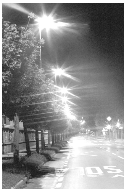
Slika 7: Slabo zasenčene svetilke CX z izbočeno kapo na Jamovi cesti v Ljubljani. Svetilke bleščijo, kar zmanjšuje vidno zaznavanje. Jamova cesta je primer nove, pretirane razsvetljave, saj je osvetljenost E_v = 90 \text{ lx} , E_h = 30 \text{ lx} - 60 \text{ lx} . Svetilka na kandelabru s previsom bi bila boljša rešitev, saj bi preprečili senco pod drevesi na kolesarski stezi, kjer je E_h 2 \text{ lx} . Jamova cesta je preosvetljena, razsvetljava je tako močna, da ni razlike, če imamo na avtomobilu prižgane ali ugasnjene luči.
