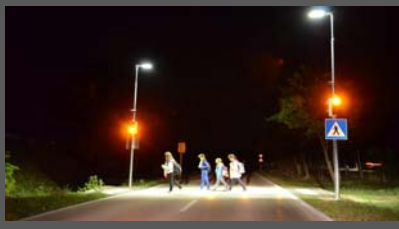
13 Bizjak: Osvetlitev prehodov za pešce in kolesarje
