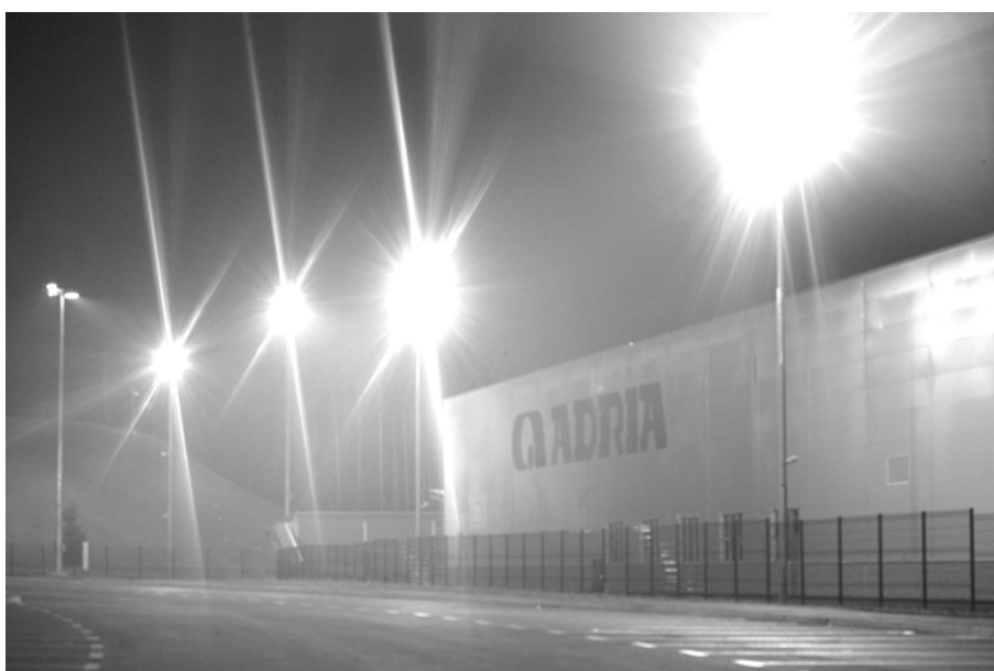
Slika 14: Nova tovarna v vasi Prečna pri Novem Mestu. Asimetrični reflektorji so uporabljeni napačno, nagnjeni so nad vodoravnico in svetijo v vse smeri neba ter močno onesnažujejo celotno Dolenjsko in velik del Slovenije. Na parkirišču je E_h = 80 \text{ lx} - 100 \text{ lx} , kar je močno pretirano. Svetloba s parkirišča se vidi 10 km daleč in omogoča iskanje tovarne na osnovi svetlobnega sija nad tovarno. Na posnetku je prikazan samo majhen del ogromnega, izjemno bleščečega kompleksa razsvetljave. Česa podobnega nisem videl nikjer v Evropi.
