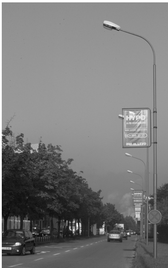
Slika 6: Svetilke Siteco CX z izbočeno kapo so ekološko sporne. V Sloveniji je večina starih kandelabrov s previsom in nagibom. Montaža novih, ne povsem zasenčenih svetilk (ali pa celo povsem zasenčenih), ki ne potrebujejo nagiba, na kandelabre z nagibom še dodatno povečuje bleščanje in svetlobno onesnaževanje. Te rešitve so najslabše in povsem nesprejemljive za okolje. Primer je z Dimičeve ulice v Ljubljani, žal pa tako na stare kandelabre montirajo vse svetilke po Sloveniji..
